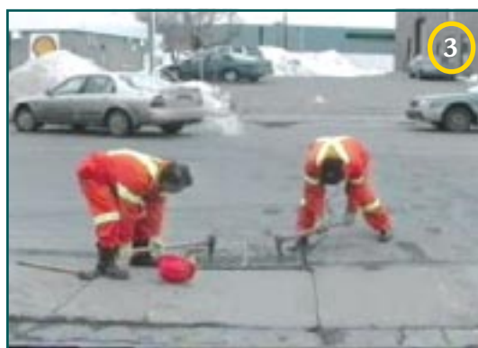
LEVÉE D'UNE GRILLE À RAINURES OBLIQUES AVEC UN PIC.
