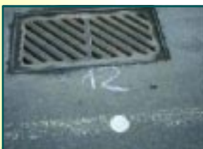
COUVERCLE : GRILLE À RAINURES OBLIQUES (POIDS DE 118 KG).
