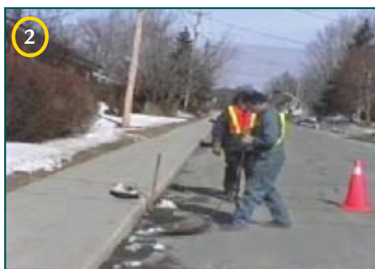
LEVÉE D'UNE GRILLE À RAINURES HORIZONTALES AVEC UN PROTOI.
