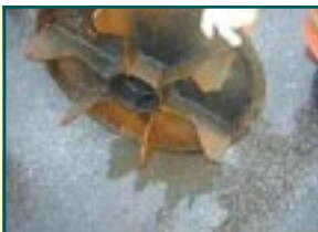
COUVERCLE : TAMPON À PATTES (POIDS DE 95 KG).
