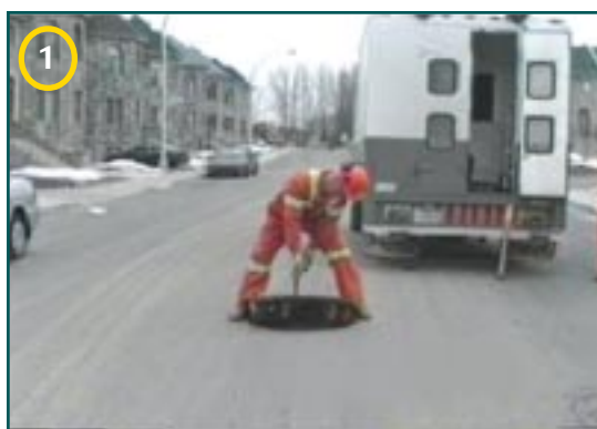
LEVÉE D'UN TAMPON À PATTES AVEC UN PIC.
